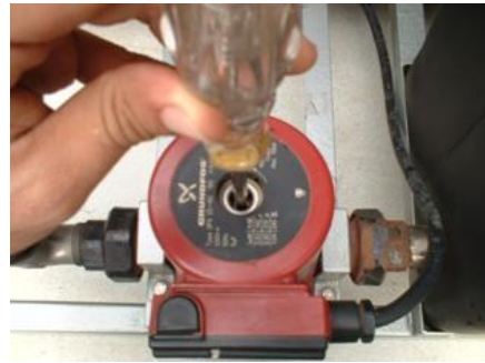
รูปที่ 3 หมุนเพลาปั๊มด้วยไขควง
