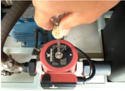
รูปที่ 2 เปิดปลั๊กอุดด้วยไขควง
